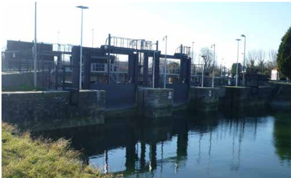
Territoire des Wateringues, ouvrage de Gravelines : pour évacuer les eaux de l'AA à la mer tout en évitant les intrusions marines Source : setec hydratec
